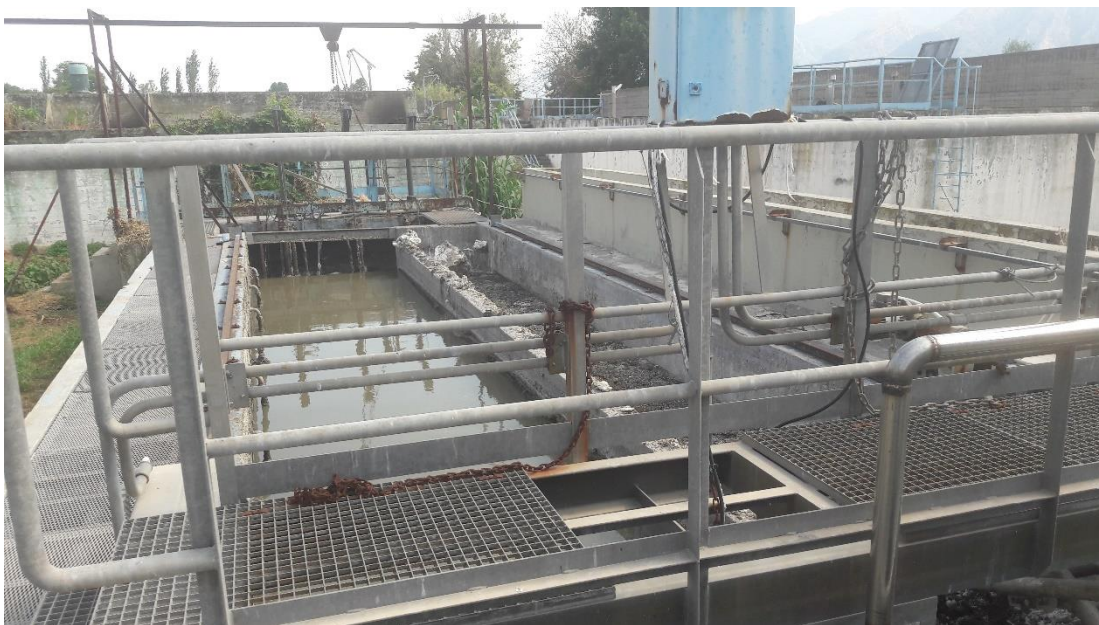
Εικόνα 3: Δεξαμενή εξάμμωσης - απολίπανσης
